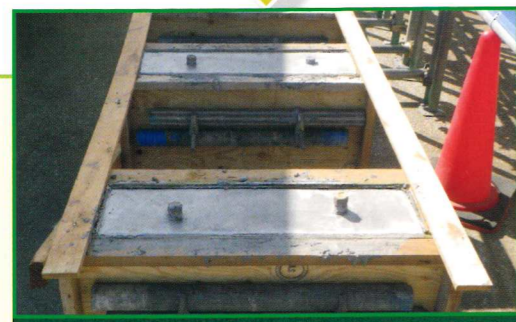
2 生コンクリートを流し込み、保水、保温などをして固まるのを待つ
