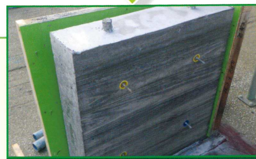
3 固まったら型枠を取り外す
