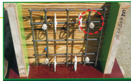
1 鉄筋を囲むように、型枠を組み立てる
